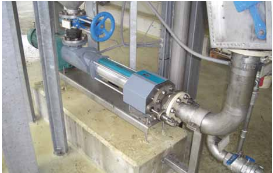
1 pav. Sumontuotas NETZSCH FSIP siurblys su xLC® technologija
