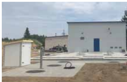
3 pav. Nuotekų valymo įrenginių rekonstrukcija Matuizų gyv., Varėnos raj.
