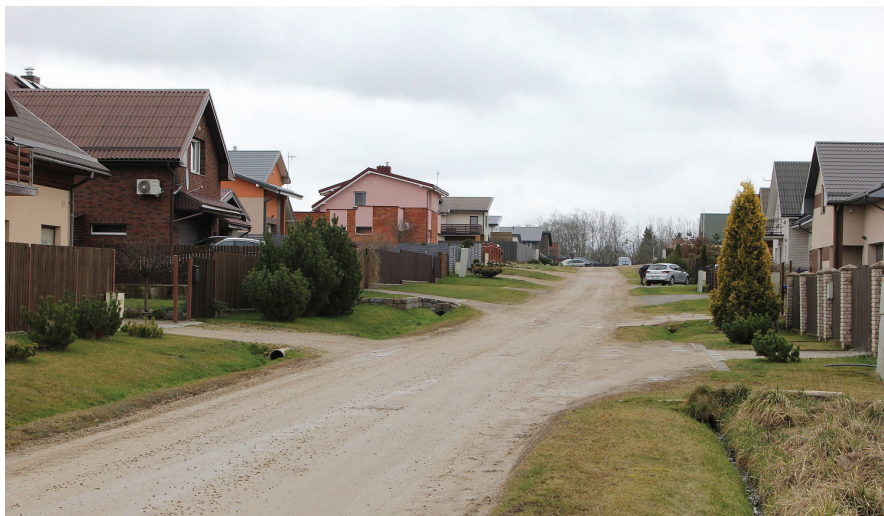
Pav. Vandentiekio ir nuotekų tinklai bus klojami Šiaulių miesto Lieporių–Šventupio gyvenamųjų namų rajone
