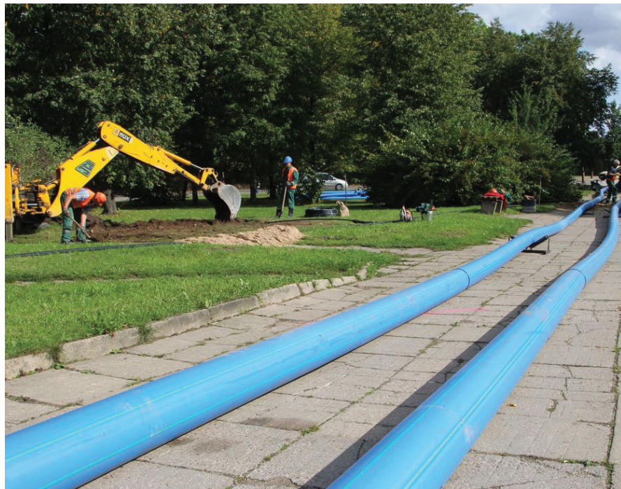
Pav. Šiauliuose rekonstruota 20,9 km vandentiekio, 27,7 km nuotekų vamzdyno ir 18,2 km paviršinių nuotekų tinklų
