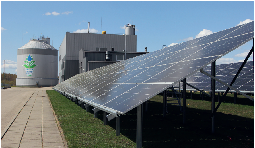
Pav. Šiaulių miesto nuotekų valykloje įrengta 500 kW galios saulės fotovoltinė elektrinė
