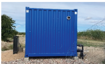
4 pav. Išvalytų komunalinių nuotekų 600 l/min. pajėgumo planuojamas regeneravimo įrenginys konteineryje (filtracija, UV)
