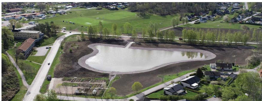
3 pav. Gamlebio miestelyje iš 80 ha drenuojamo baseino įrengtas 1,4 ha ploto, 5000 m 3 tūrio paviršinių nuotekų kaupimo tvenkinys
