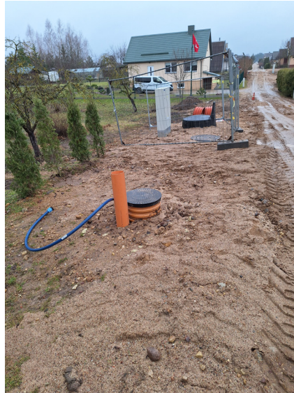
5 pav. Įrengti šulinėliai nuotekų išvadams prijungti Slyvų g.
