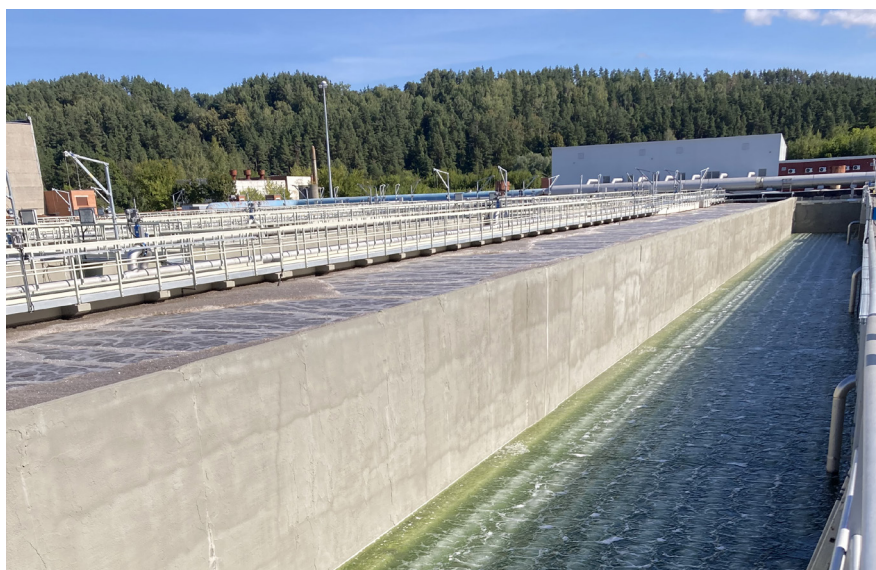
2 pav. Rekonstruota pertvara tarp veikiančio bioreaktoriaus ir ištuštinto bioreaktoriaus
