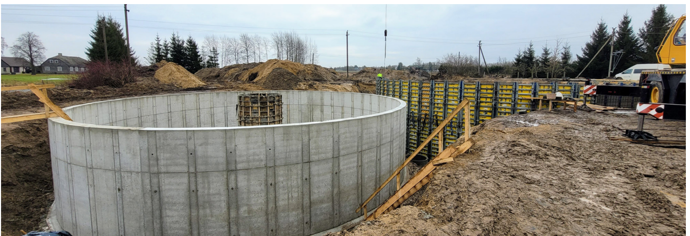
4-5 pav. Kelmės nuotekų valyklos rezervuarų statybos procesas
