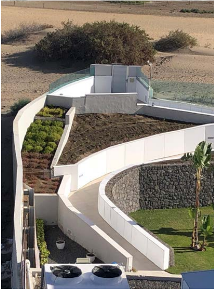
2 pav. Automobilių aikštelės stogas, apželdintas remiantis gamtiniais sprendimais
