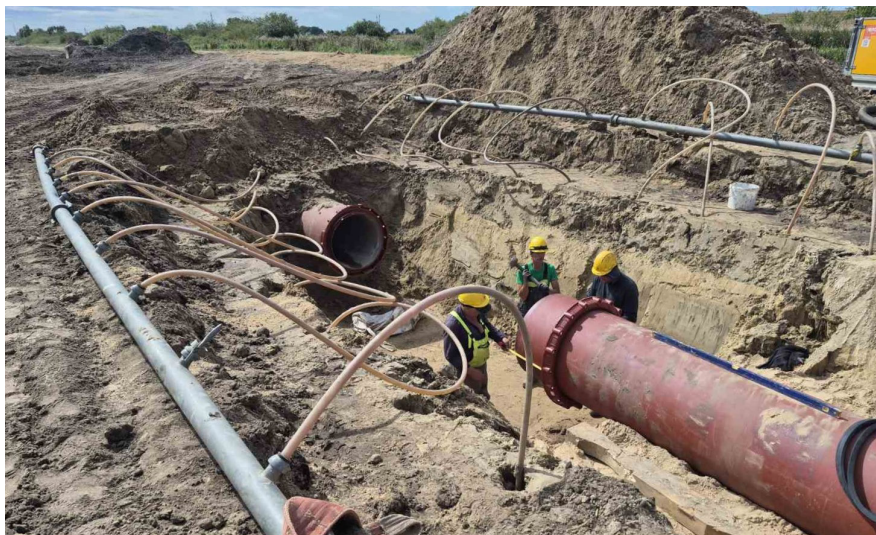
2 pav. NVĮ slėginės linijos statyba
